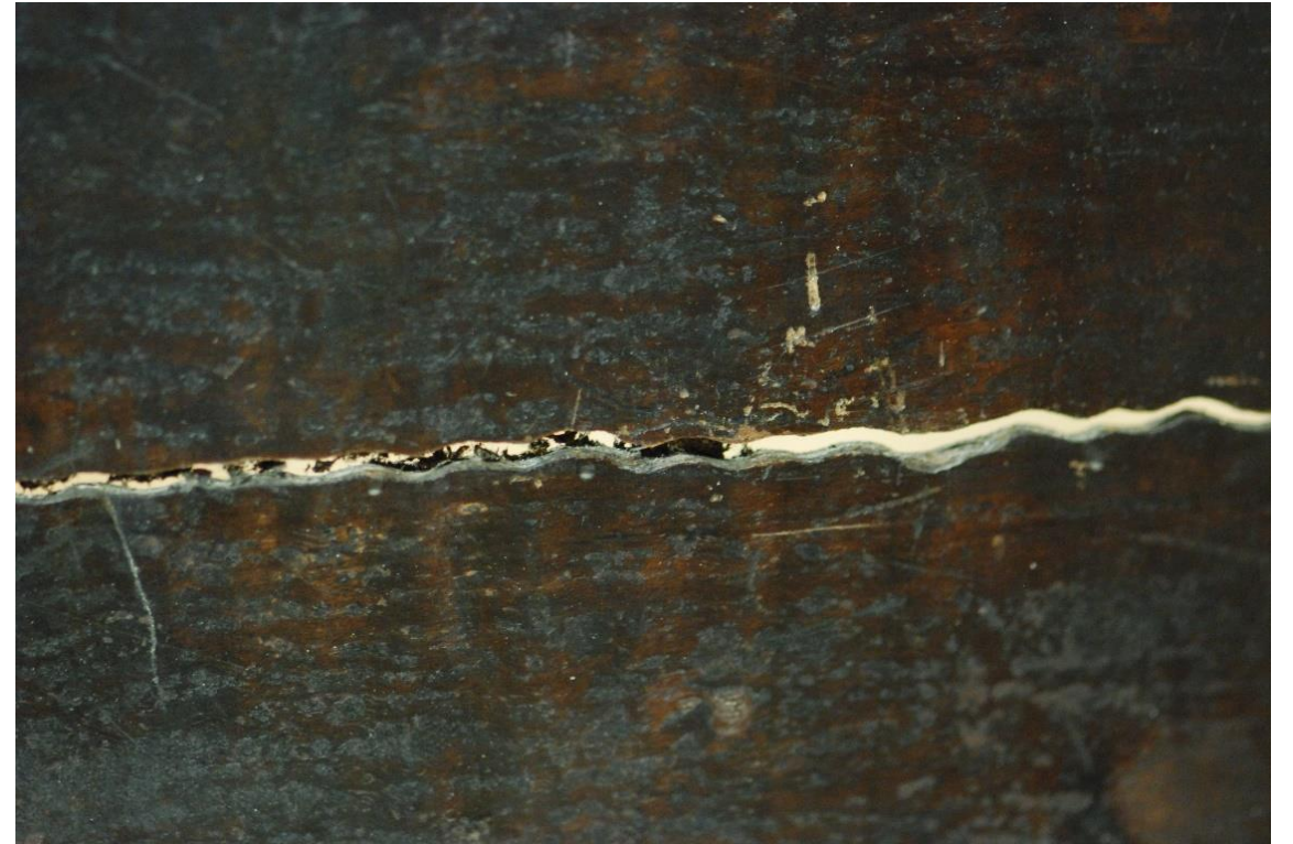
prasklina lubu se zbytky tmelu po předchozích opravách
